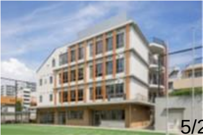
(四谷小学校増築校舎 竣工時)
