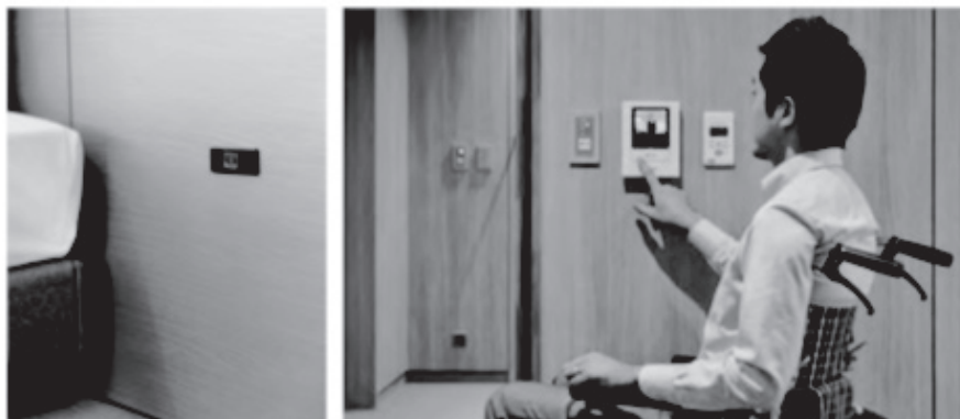
【写真25.1】コンセント、スイッチの高さの例
