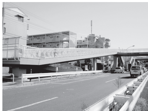
【写真10.1】 スロープの設置例
