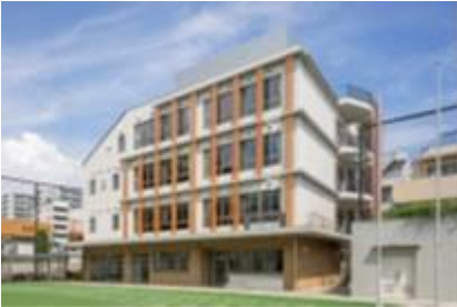
(四谷小学校増築校舎 竣工時)
