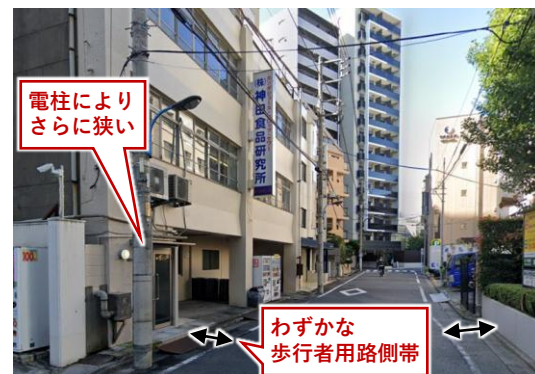
②歩行者用路側帯が狭く電柱が残る特別区道36-880号線
