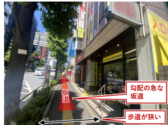
③歩道が狭く勾配が急な大久保通り
