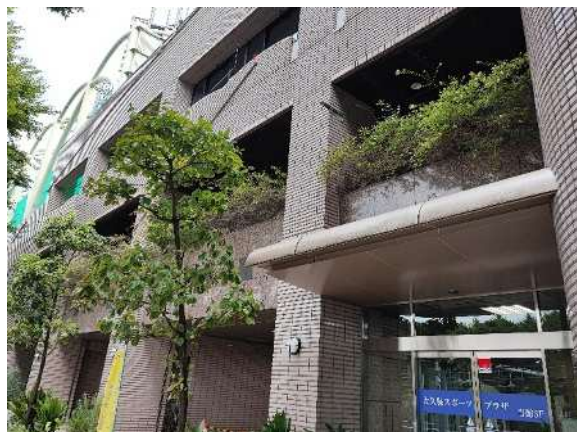
大久保スポーツプラザの壁面緑化
