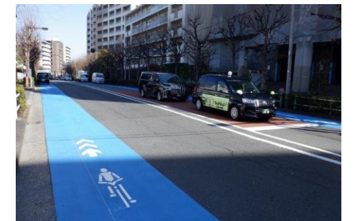
自転車通行空間 施工後（小滝橋通り）
