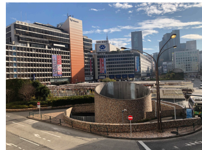
6 西口ロータリー デッキ上は西口ロータリー全景を眺められる視点場になっている
