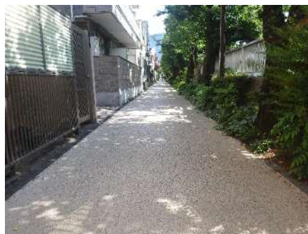
(透水性カラー舗装整備後)
