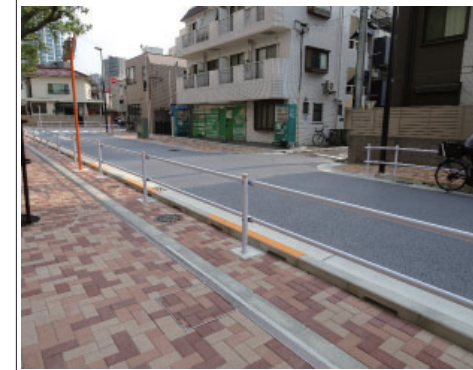
㉜中央南地区・西側道路（北→南）
