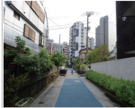
㉒暗渠（北→南）
