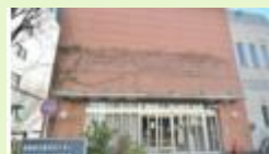
防災センター
