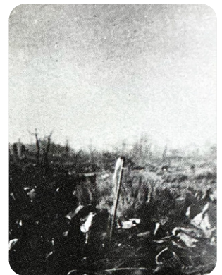
焼け跡に水道管が見える。(昭和22年頃)
