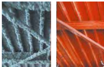
アスベスト除去等工事 (施工前) (施工後)
