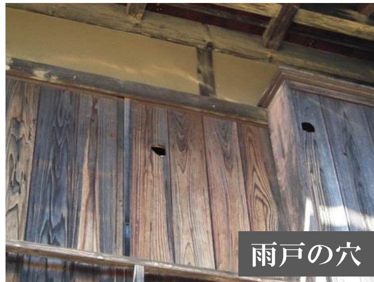
木材の劣化・腐朽
