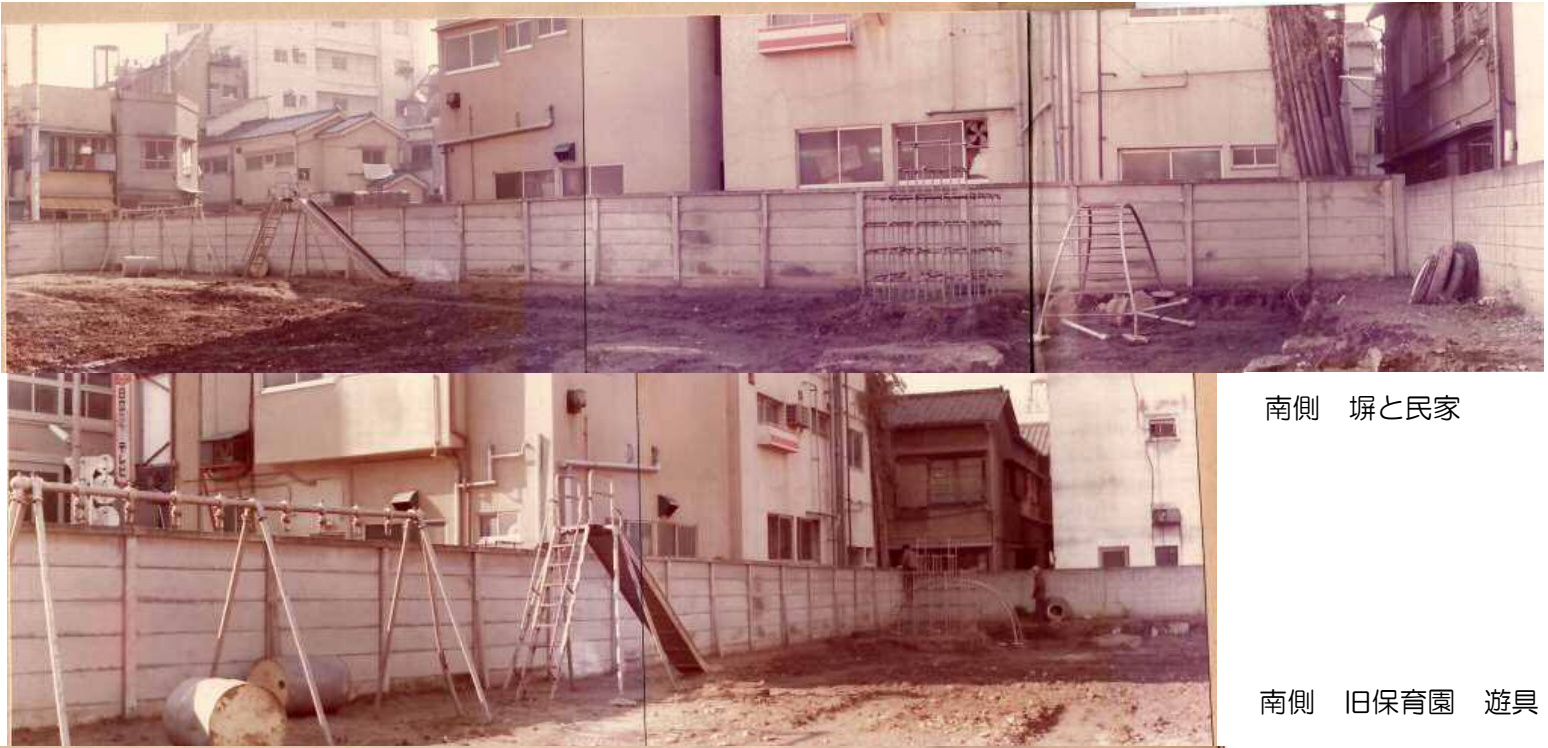
■榎町公園造成前の状況（旧榎町保育園建物撤去後 昭和 51 年 11 月 25 日）
