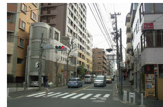
幹線道路沿いの耐火建築物
