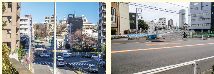
現在道路整備工事が進む環状 4 号線（目白台）（河田町周辺）
