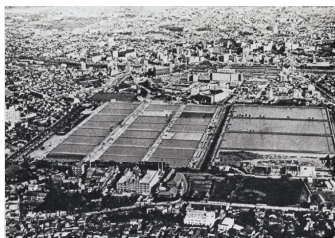
淀橋浄水場（昭和36年）
