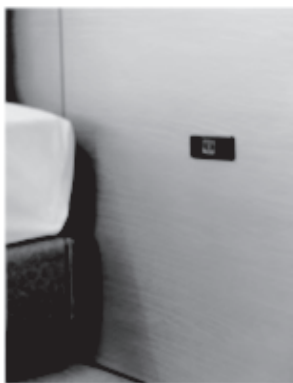
【写真25.1】 コンセント、スイッチの高さの例
