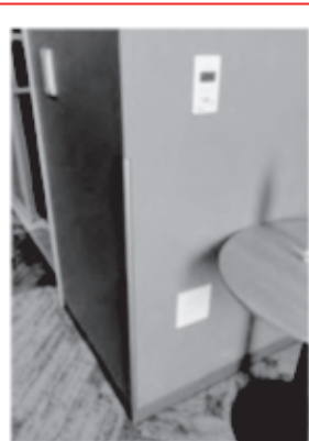
【写真25.1】 コンセント、スイッチの高さの例
