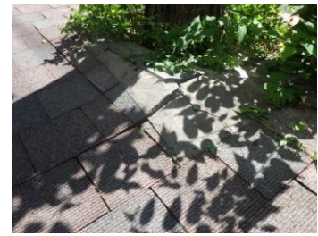
舗装のガタツキ補修箇所
