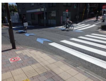
横断歩道部の段差 1cm 化予定箇所
