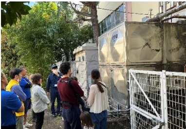
受水槽 受水槽の設置場所の確認を行った。
