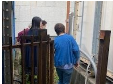
受水槽での給水訓練 訓練参加者が実際にバルブをひねり、給水することを確認していた。
