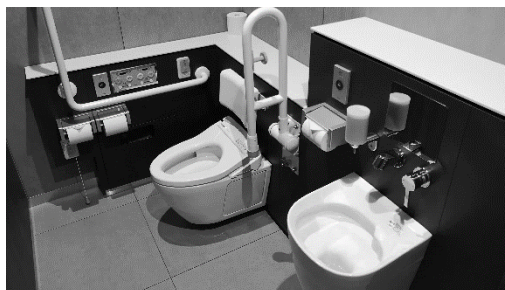
・コントラストがとれており、便器、手摺が認識しやすい
