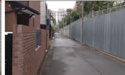
ルートA No. 6 計画地の南側接道を望む。 フェンスで隠れているが写真右手の計画地には擁壁が立ち上がり奥まで続いている。
