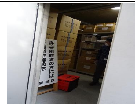
【防災倉庫の点検】
