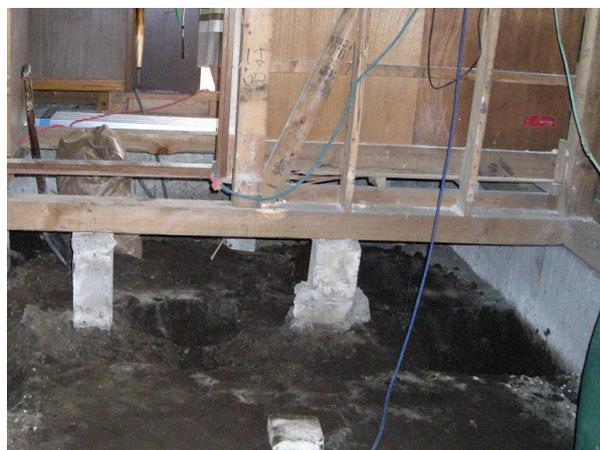
図1-24 布基礎のない筋かい壁
