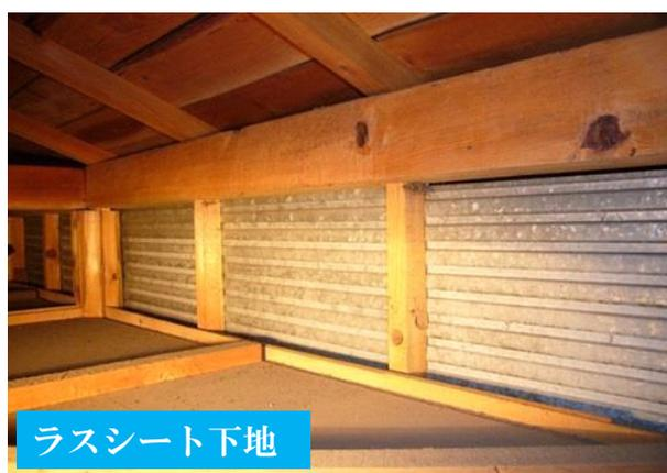
図1-15 ラスモルタル塗りの木ズリ下地とラスシート下地
