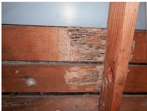
外観上(左図)、劣化が確認されない場合でも右図のように内側から仕上げを引き剥がすと劣化が確認されることもあります。
