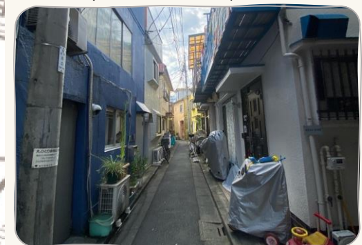
狭あい道路・老朽住宅
