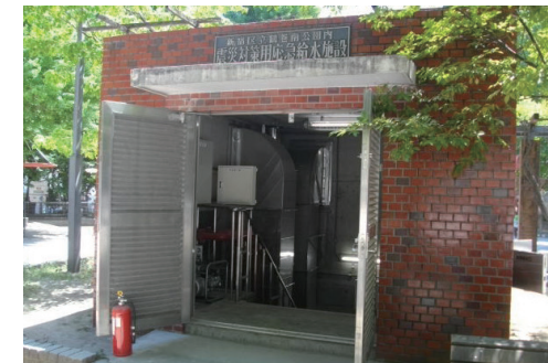
鶴巻南公園応急給水槽
