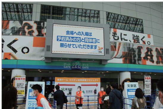
東京ドーム外観
