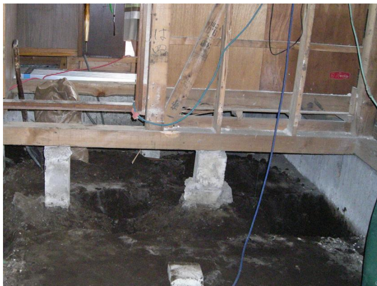
布基礎のない 筋かい壁
