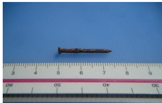
劣化したラスボード釘
