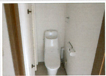
①手すり設置(トイレ)
