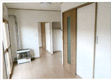
②段差解消(居間・洋室)
