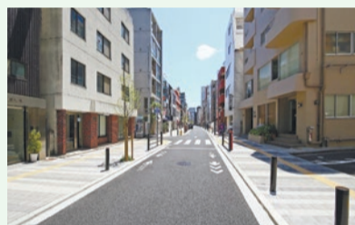
無電柱化した道路
