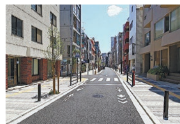
無電柱化した道路
