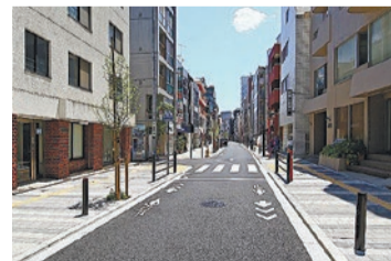
無電柱化した道路
