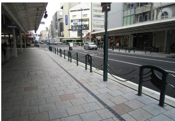
道路改良による歩道の拡幅の事例(京都市四条通り)
