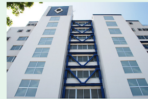
マンションの耐震改修工事の事例
