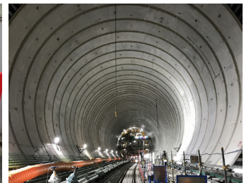
環状七号線地下広域調整池の整備
