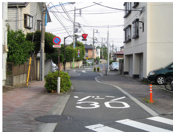
速度抑制や道路舗装による歩行者に配慮した道路環境(西落合)
