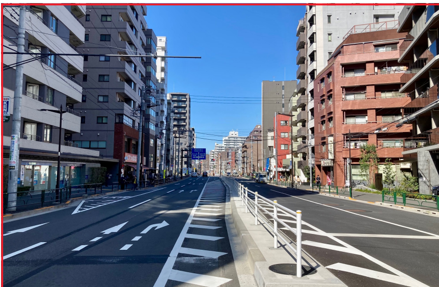
整備が進む環状第3号線(外苑東通り)
