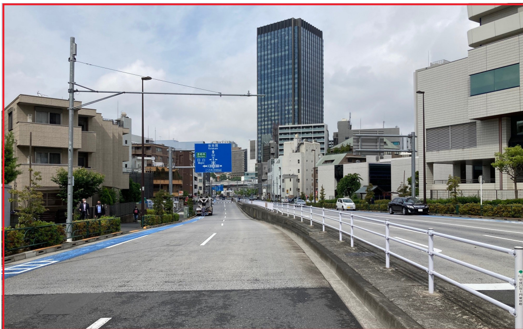
整備が完了した放射第25号線
