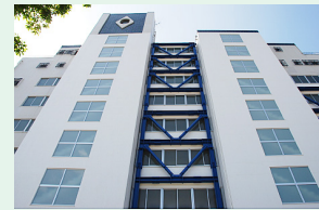
マンションの耐震改修工事の事例
