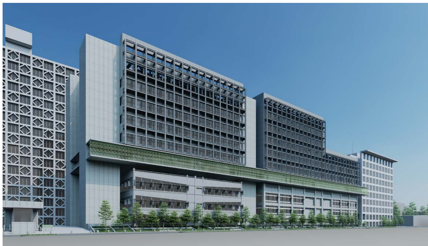
外観全体イメージ(南西より)
