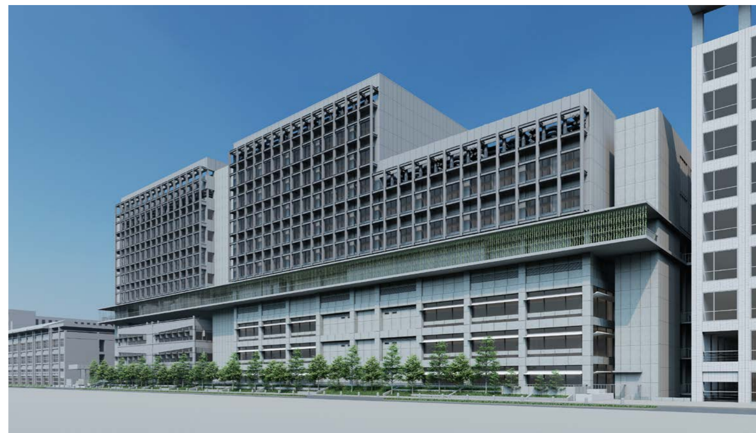
外観全体イメージ(南東より)
