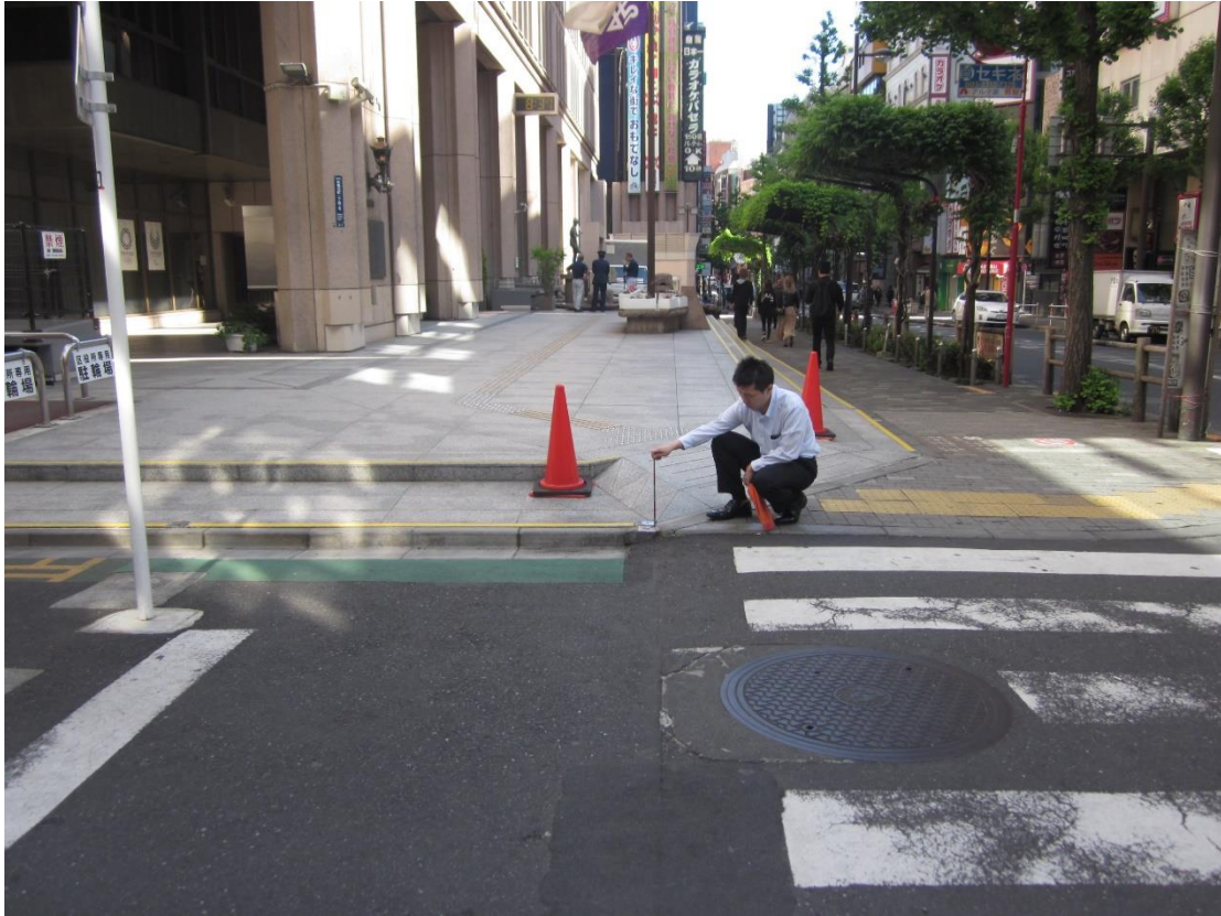
P1 (区コンクリート杭)
