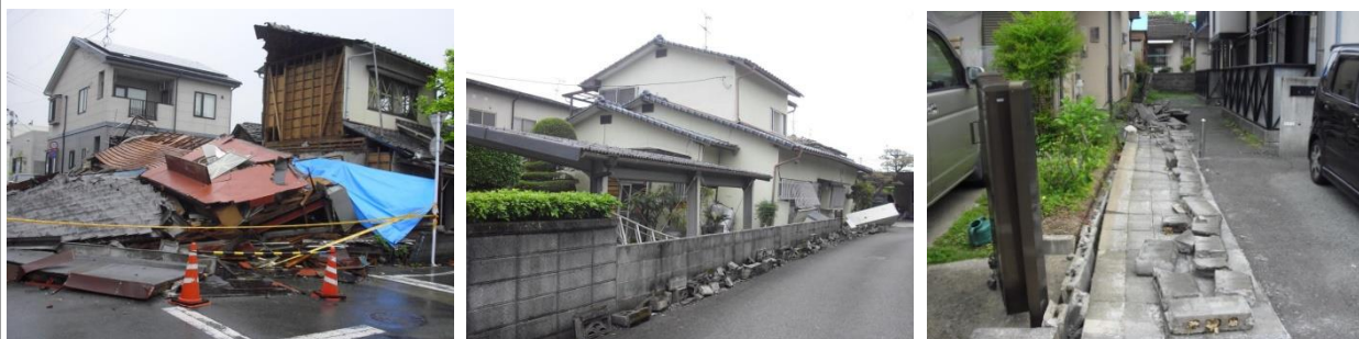
熊本地震の被害状況
