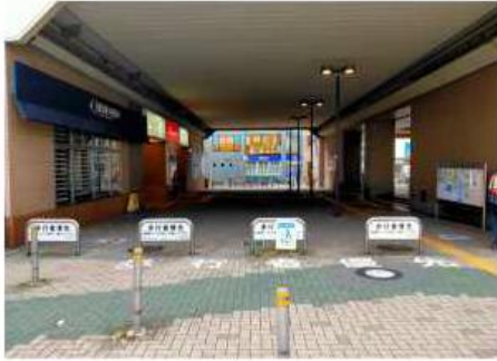
高架下商業施設の入り口
