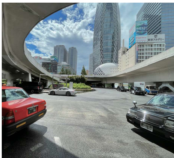
立体的、重層的な新宿駅西口の景観
