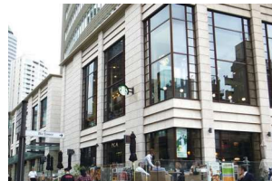
建築物と一体的な屋外広告物
