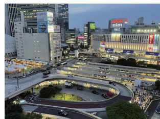
【10-3 新宿駅西口エリア】 立体的な景観の魅力をもつ立体交差
