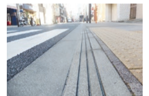
▲段差を小さくしてバリアフリー化した歩道
