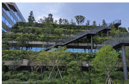
壁面緑化(コモレ四谷) 提供：UR都市機構
