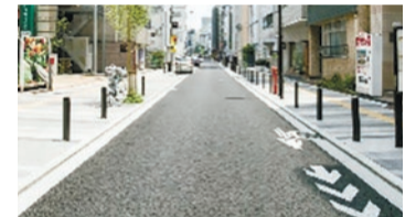
▲無電柱化した道路 (道路の無電柱化整備)
