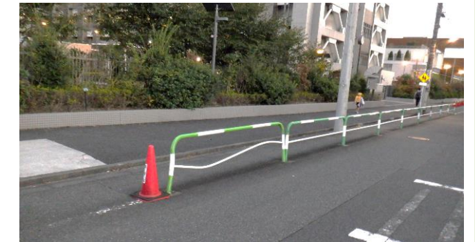
ガードレール等の破損
