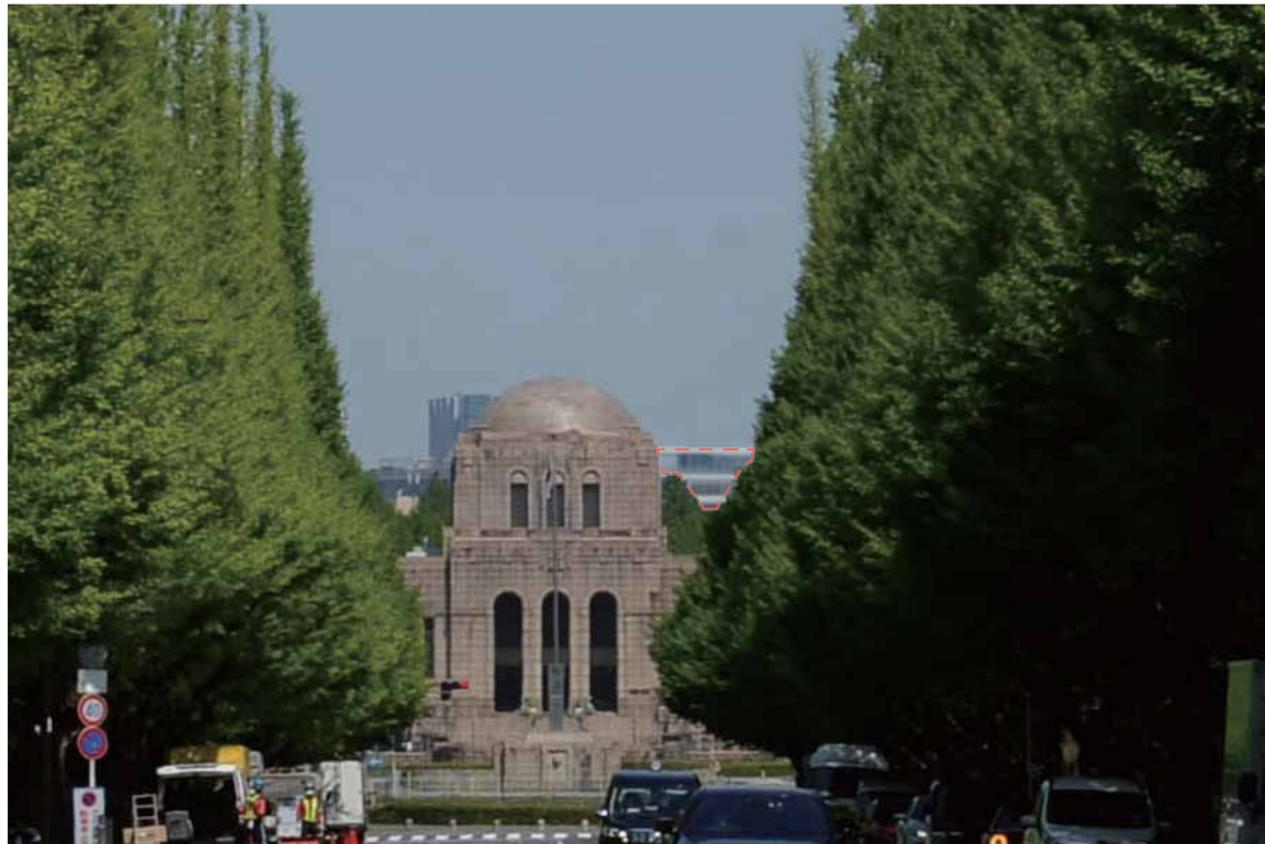
パネル塗装案の遠景での見え方は、スパンドレル部が目立つため、光輝合金パネルの採用を検討します。
