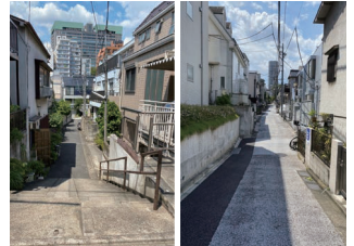
【1-2 四谷北エリア】 斜面に沿って広がるまちなみ
