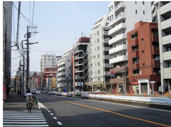
幹線道路沿道建物の不燃化の事例(外苑東通り)
