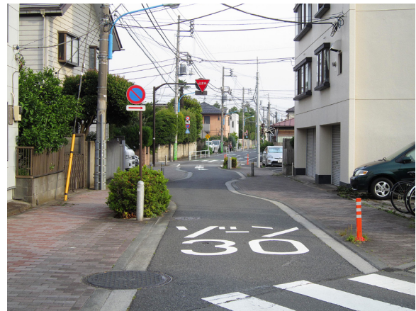
速度抑制や道路舗装による歩行者に配慮した道路環境(西落合)
